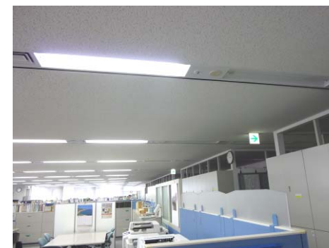
蛍光灯取り外し（執務室内廊下）
