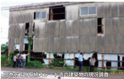
石巻市での石綿スレート造の建築物の現況調査
