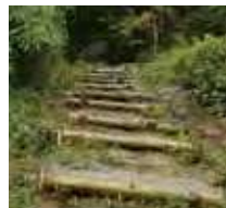
青年によるフィールド整備(階段作り)
