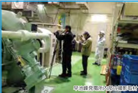
早池峰発電所内部の撮影取材
