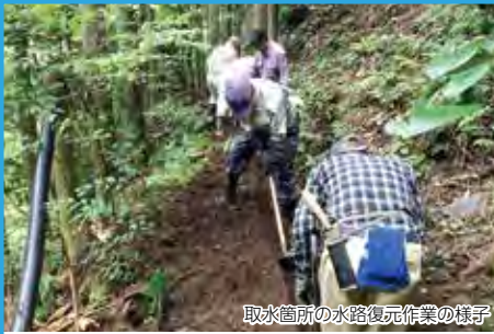
取水箇所の水路復元作業の様子
