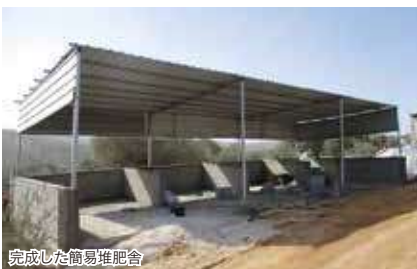
完成した簡易堆肥舎
