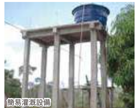
簡易灌漑設備
