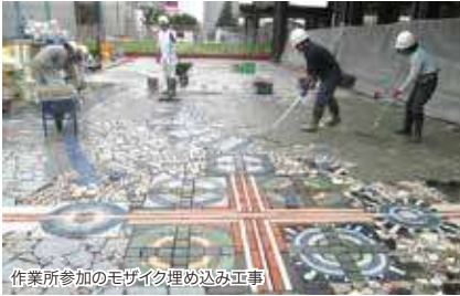
作業所参加のモザイク埋め込み工事
