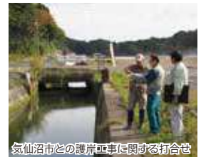
気仙沼市との護岸工事に関する打ち合わせ
