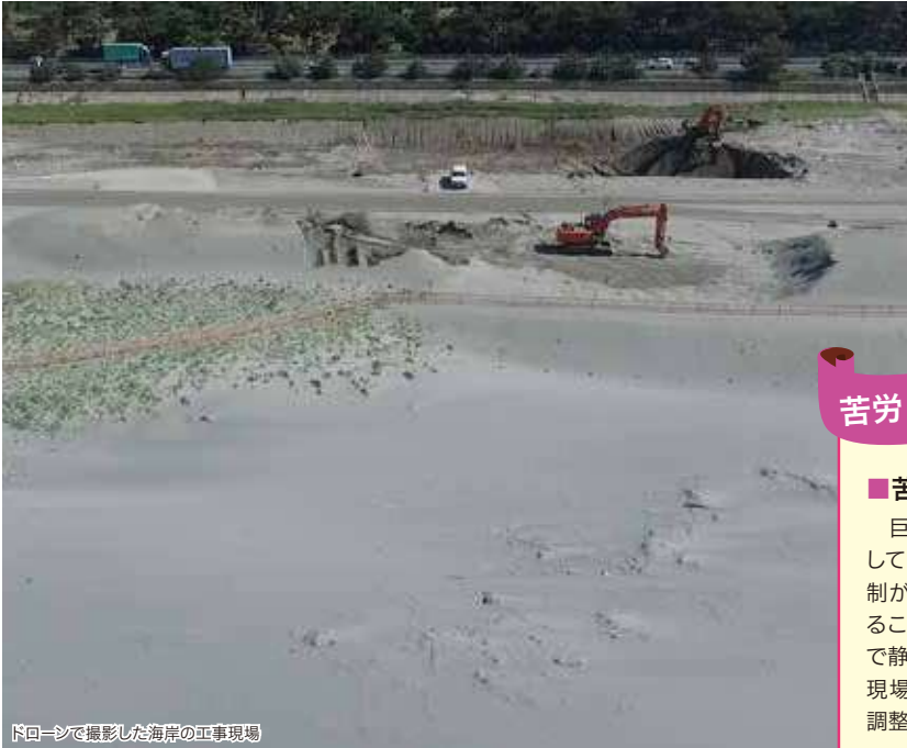
ドローンで撮影した海岸の工事現場
