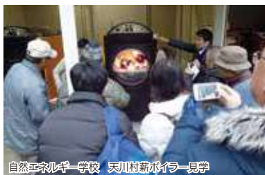
自然エネルギー学校 天川村薪ボイラー見学
