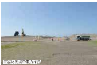
巨大防潮堤工事の様子
