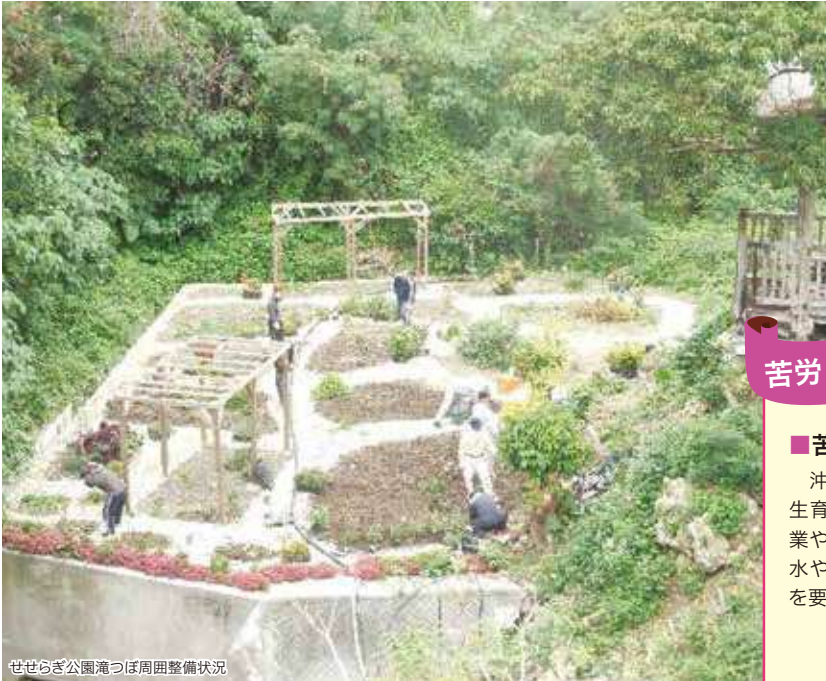
せせらぎ公園滝つぼ周囲整備状況
