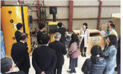
ボイラー実機研修
