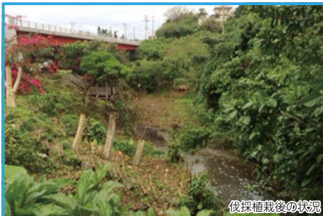
伐採植栽後の状況
