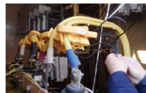
省エネ診断の電力計測器 取り付け作業
