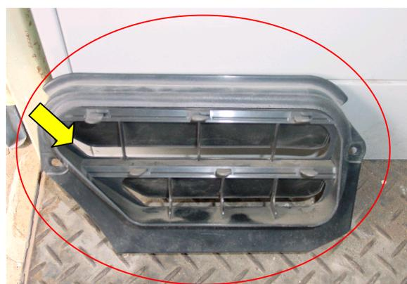
図 8 (3) 排出口の薄ゴム板トラップ
