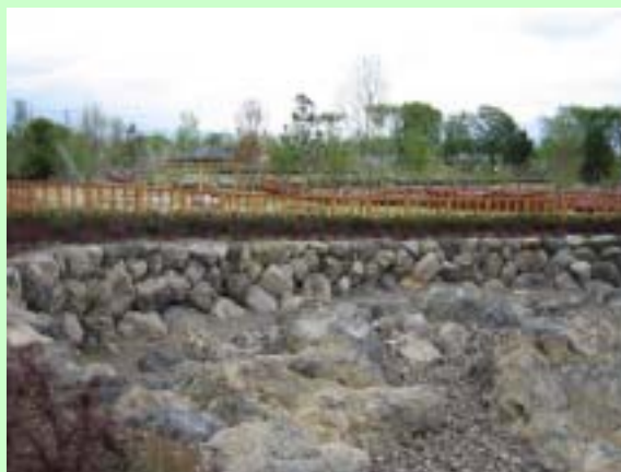
e. 発生石材の利用（石積擁壁）
