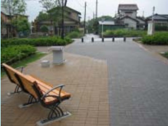
i. ペーパースラッジ灰含有インターロッキングブロック等を用いた舗装
