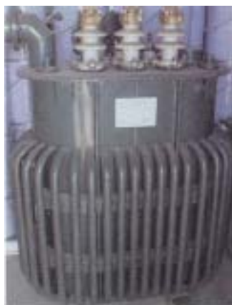
トランス (変圧器)
