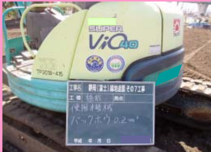
k. 低騒音型・排出ガス対策型建設機械の使用
