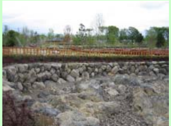
e．発生石材の利用（石積擁壁）
