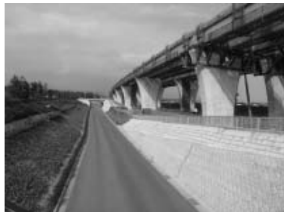
- 2 第2東名自動車道 高架下緑地整備予定地
