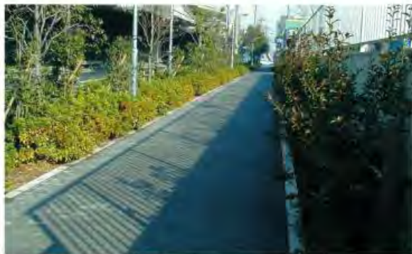
写真7 光触媒を塗布したブロック敷設の様子 歩道680m (1,400m 2 )
