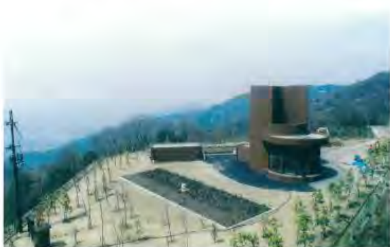
写真2 トンネル型システム
