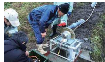
出力150wほどの小さな発電機でも住居の電灯や冷蔵庫くらいはまかなえる
