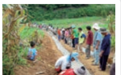
村民総出で行われた栽培地に続く作業道の補修
