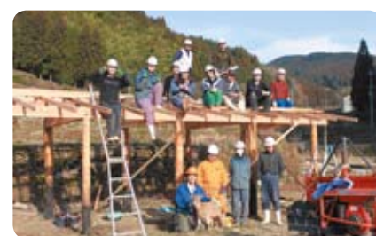
ヤギ小屋棟上げ
