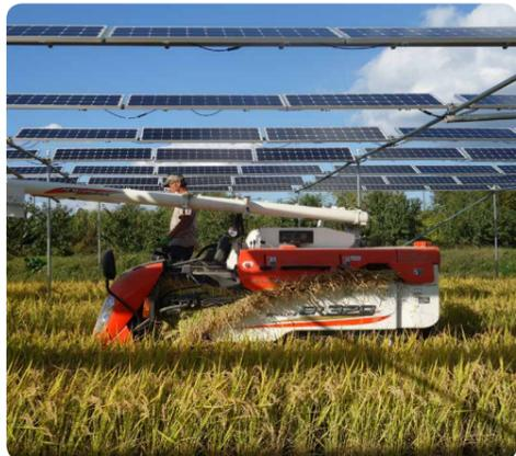
団体の幹事で農家の秋葉慶次さんが、自身の田んぼに手作りしたソーラーシェアリング。約800平方メートルの田んぼに高さ3メートルの支柱を立て、約300枚の太陽光パネルを設置している。ほかにも耕作放棄地にソーラーパネルを設置し、その下でわらびを育てるなど、農家として再エネ導入に積極的に挑戦している。「米は儲からなくなり、耕作放棄地も増えている。そんな農家にとって発電は、定期収入が得られる魅力的な事業だと思う。ただソーラーシェアリングをうたいつつ、発電だけで農作物は育てない事例も少なくない。農業と発電を両立させるために、今後どのような形で広めていくべきか考える必要がある」と秋葉さんは語る。
