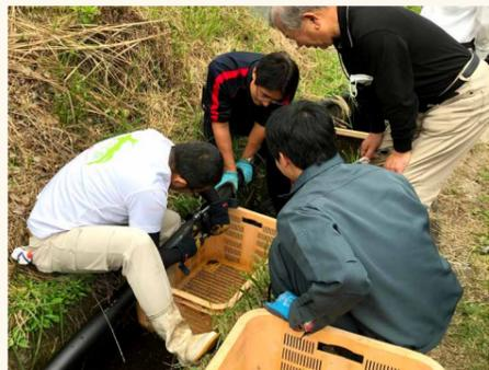
小水力発電施設設置作業で最も大変だったという、導水管接合作業の様子
