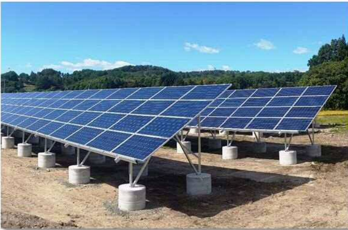
山形県内の住民・NPO・企業でつくりあげた市民地域共同太陽光発電所 場所：山形県川西町 設備規模：200kW
