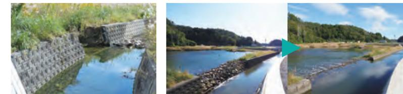
水の循環を確保するため、河川護岸を開削 干潮時に湿地の水が川に流出し、満潮時に海水が流入する(右)
