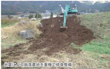
地震による崩落農地を重機で修復整備
