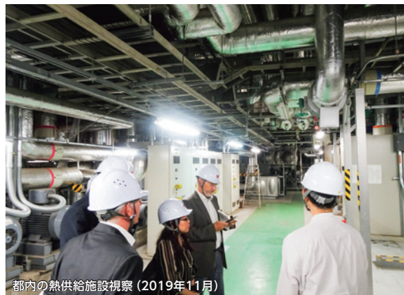
都内の熱供給施設視察 (2019年11月)
