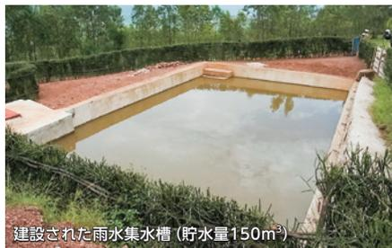
建設された雨水集水槽（貯水量150m³）
