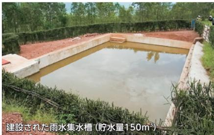
建設された雨水集水槽 (貯水量150m<sup>3</sup>)
