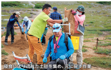
侵食により流れた土砂を集め、元に戻す作業
