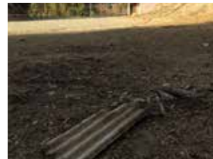
解体現場終了後現場で発見されたスレート板
