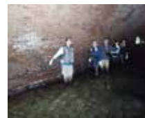
明治 36 年頃構築肥薩線久留味川暗渠探索
