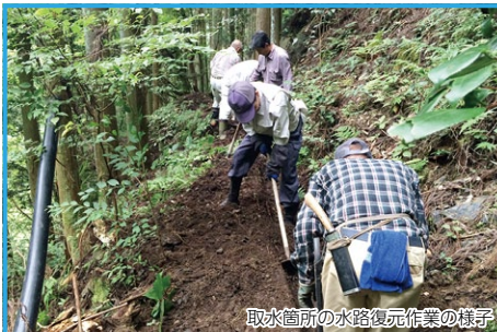
取水箇所の水路復元作業の様子
