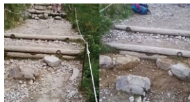
指導の下補修 左:補修前 右:補修後
