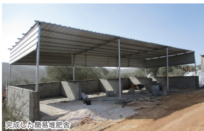
完成した簡易堆肥舎
