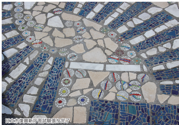
目立市復興新庁舎試験張り完了
