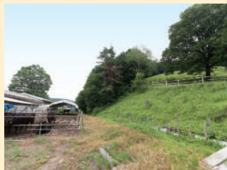
学校周辺が土砂災害警戒区域となっているため、地震と合わせて牛の避難想定をしている
