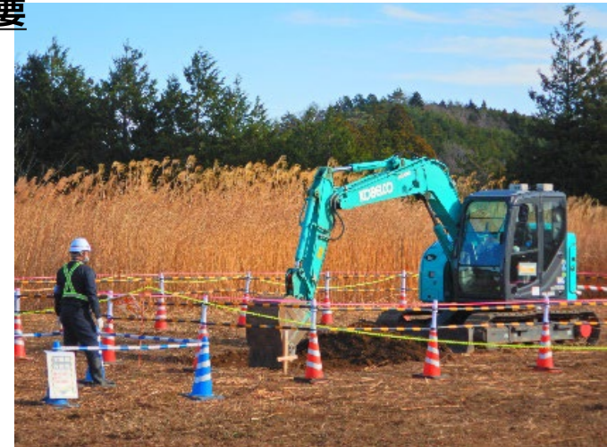
農地除染（表土の剥ぎ取り）
