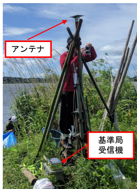
図(1)-5 伊豆沼の岸に設置したRTK-GNSS基準局の設置状況
