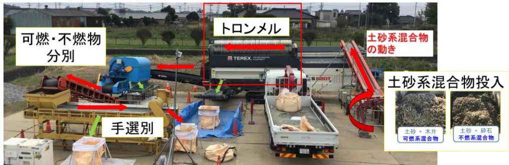
写真 1.1 実機試験の様子
