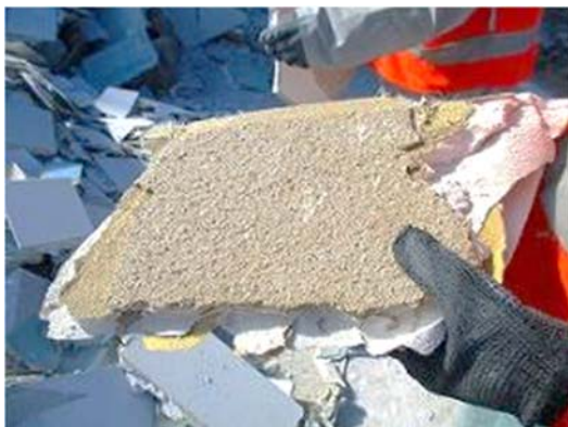
写真(4)-11 付着物を剥がすことができない廃石膏ボードはセメント原料となる
