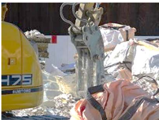
写真(4)-3 付着物がある金属類を重機で折り、付着物を剥がしている状況
