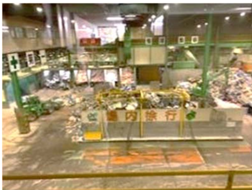
写真(4)-13 混合廃棄物処理ヤード全景（稼働率80%程度の様子）
