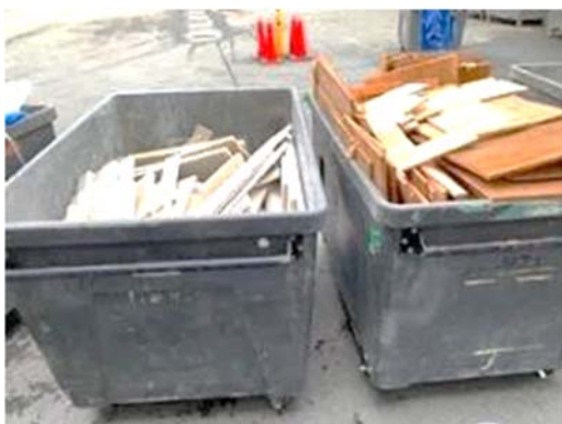
写真(4)-21 コンテナ (1 m 3 ) 受入直後の様子 (左：廃石膏ボード、右：廃木材)
