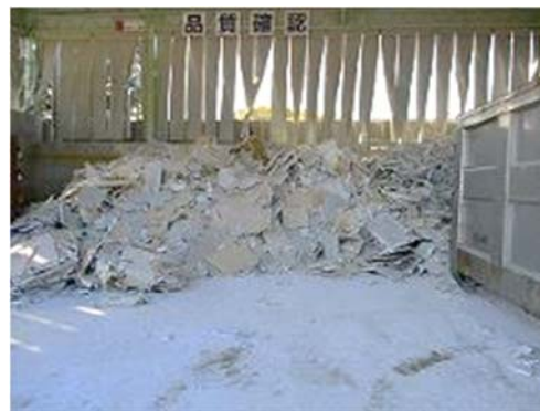
写真(4)-12 分別後の廃石膏ボードストックヤードの様子
