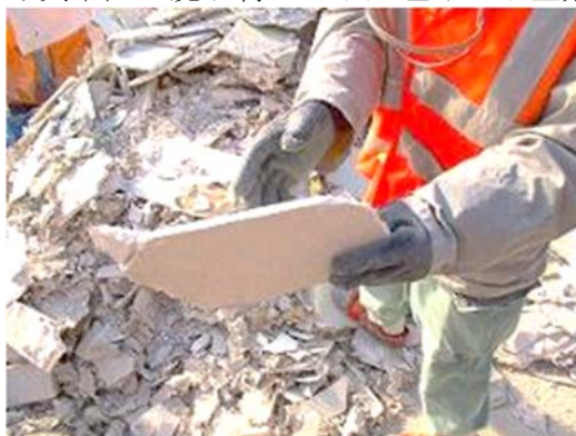
写真(4)-10 廃石膏ボード以外の板状建材を手選別で除外している状況
