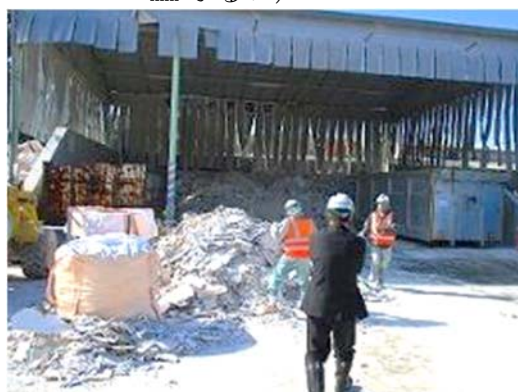
写真(4)-8 廃石膏ボード処理ヤード全景
