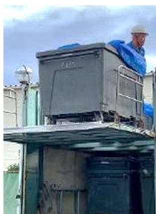
写真(4)-20 雨天時にコンテナ上部にブルーシートをかけて水濡れを防止している様子
