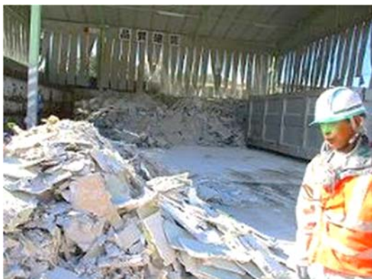
写真(4)-9 手前が未分別の廃石膏ボード、奥は分別済みの廃石膏ボード
