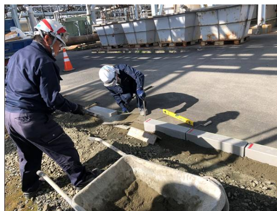
写真4.4.2 ジオポリマー製ブロックの設置状況
