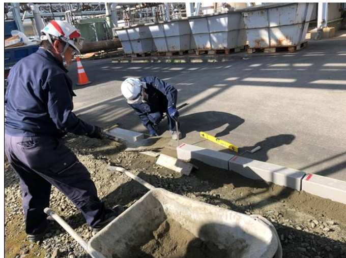
写真4.4.4 ジオポリマー製境界ブロック設置状況
