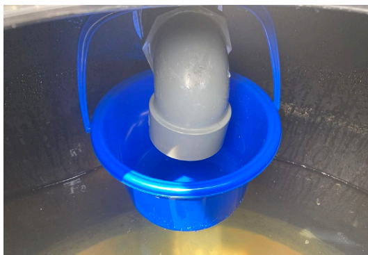
図-3.5.4 ひと雨ごとの発生水を採水するために各集水管の末端に小型容器を設置した状況
