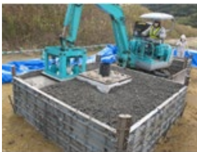
図-4.2.7 振動締固め状況
