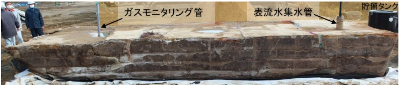
図-4.5.13 解体時の固化式埋立層の観察状況
