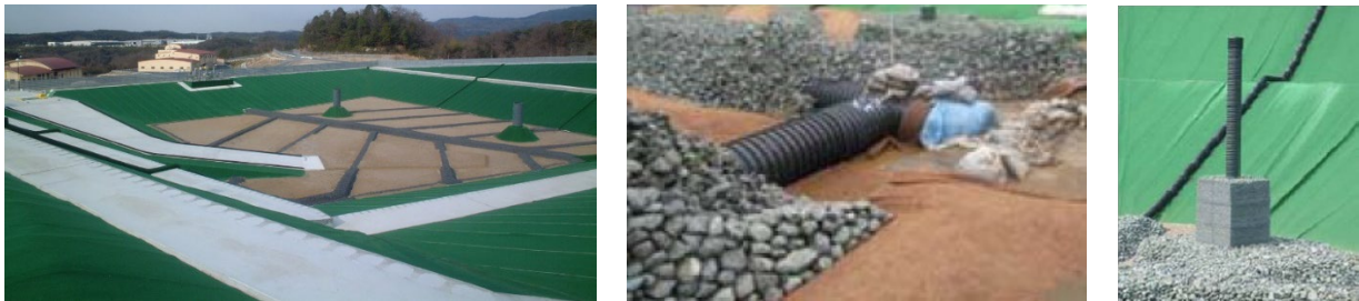
図-3.2.3 従来型処分場の例 (底部集排水管及び堅型ガス抜き管周辺のフルター材設置状況)
