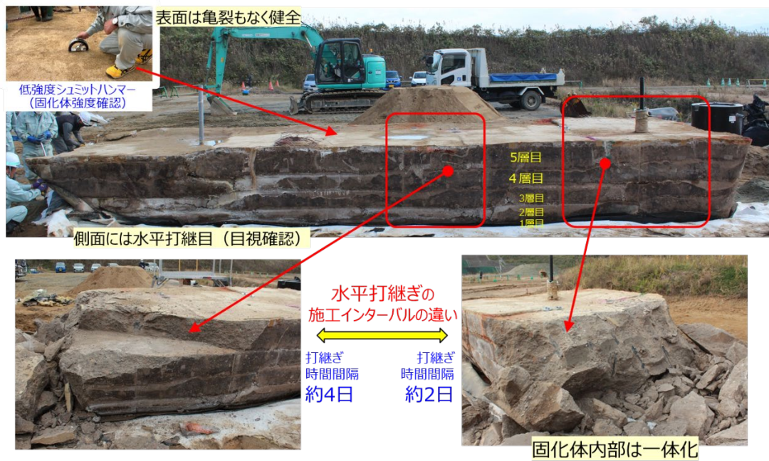
図-4.5.18 固化式処分場解体時の埋立層の観察状況
