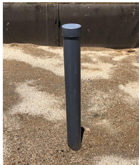
図-3.5.5 ガスモニタリング管 (左:設置前の全体像、右:設置後の地上部)
