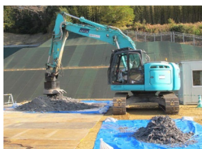
図-0.3 磁力選別の施工状況
