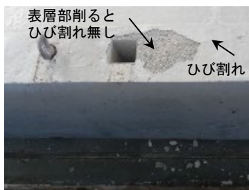
写真 4.2.5 ひび割れ深さ確認
