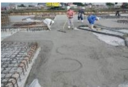
写真 4.2.5 レベルコン打設状況
