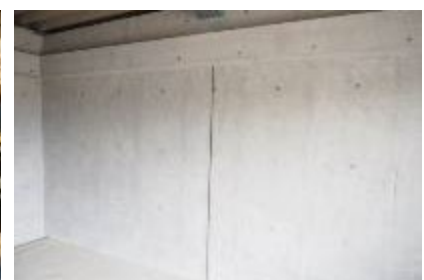
写真 4.2.7 壁部施工後の状況
