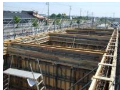
写真 4.2.10 レベルコン打設状況 写真 4.2.11 基礎耐圧盤打設状況 写真 4.2.12 壁部施工状況①
