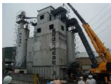
写真 4.2.1 PCa 工場の外観
