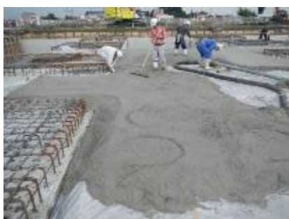
写真 4.2.10 レベルコン打設状況 写真 4.2.11 基礎耐圧盤打設状況 写真 4.2.12 壁部施工状況①
