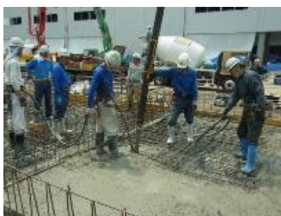
写真 4.2.10 レベルコン打設状況 写真 4.2.11 基礎耐圧盤打設状況 写真 4.2.12 壁部施工状況①
