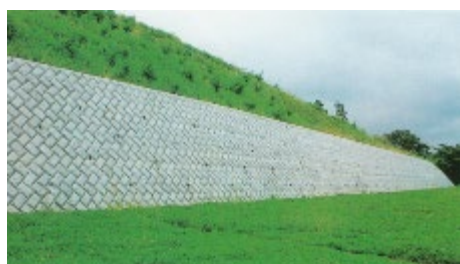
写真 3.2.1 積みブロック施工例
