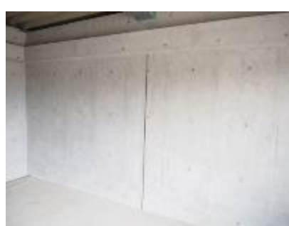
写真 4.2.14 壁部施工後の状況
