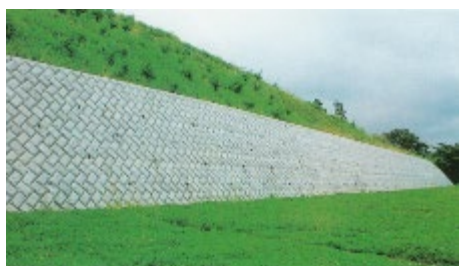
写真 3.2.1 積みブロック施工例
