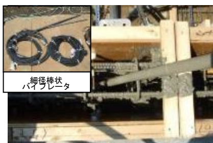
写真 4.2.6 壁部施工状況
