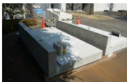
写真 4.2.2 バルコニー外観
