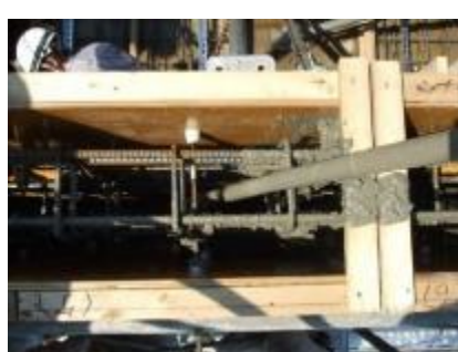
写真 4.2.13 壁部施工状況②
