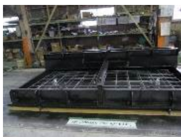
写真 4.2.2 型枠・配筋状況
