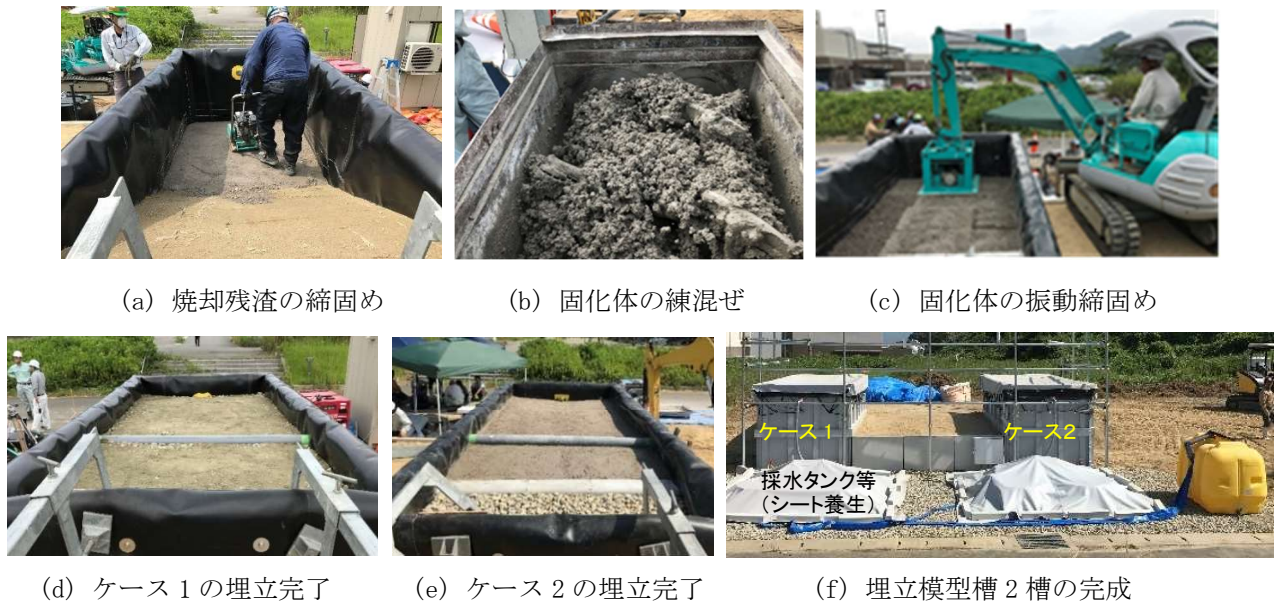
図 4.2.1 埋立模型槽を用いた施工試験の施工状況
