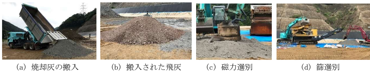
図 4.1.1 焼却残渣の前処理システムの施工試験状況
