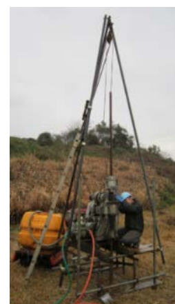
図 7 ボーリング作業
