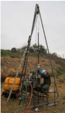
図 3 ボーリング作業
