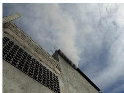
(4) 排ガス処理施設無し（煙突もなく、最上階から NO<sub>x</sub> と煙）
