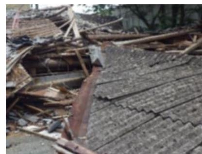
図 1 スレート屋根を補修する家族（上）と地震で倒壊したスレート屋根家屋（下）
