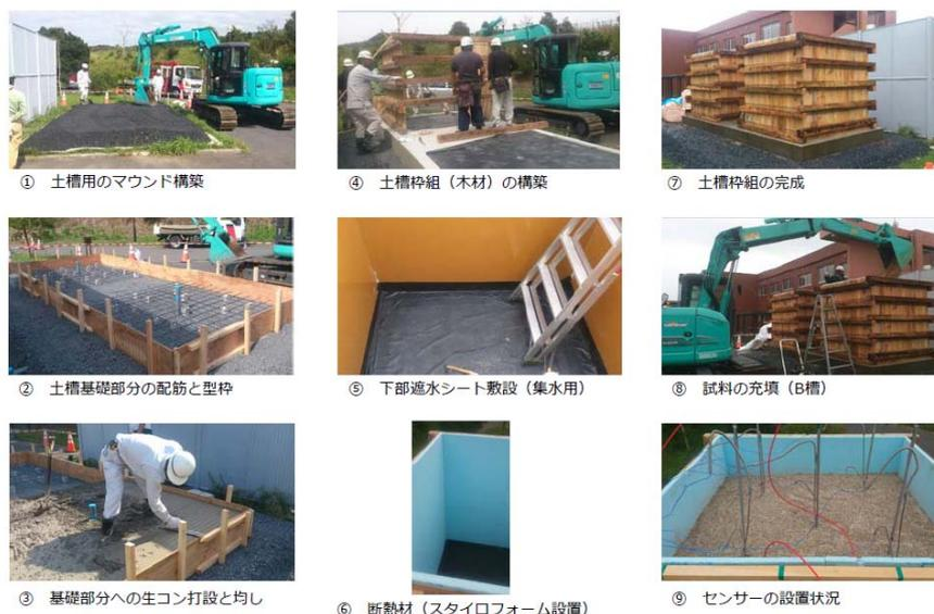
図 3.1 屋外模擬土槽の製作工程
