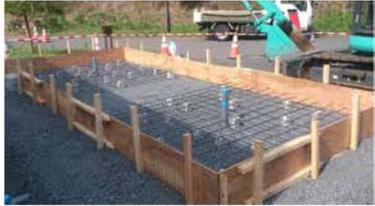
② 土槽基礎部分の配筋と型枠
