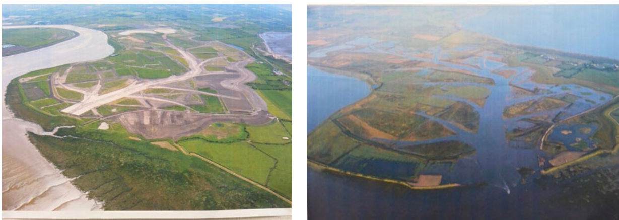
図(3)-17 掘削によってクリークが作られ、湿地が再生された
