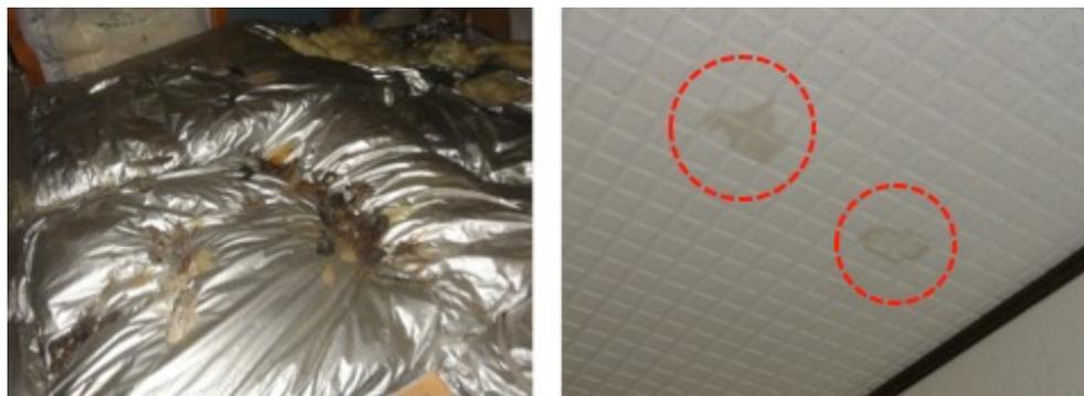
図(3)-11 テンが繁殖に利用した天井裏の様子（左）と糞尿による天井の染み（右：点線内）
