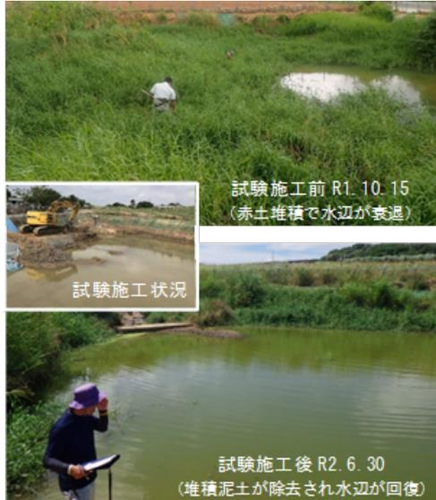
図5.4.1. 新川地区第2沈砂池の状況
