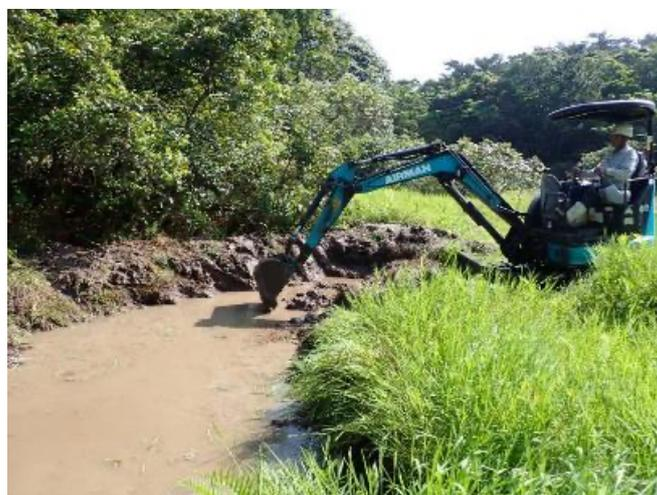
図2.4.14. 重機による保全池掘削
