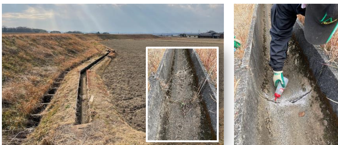
図1—8 シリコン変性樹脂を用いた農業用水路の修理状況
