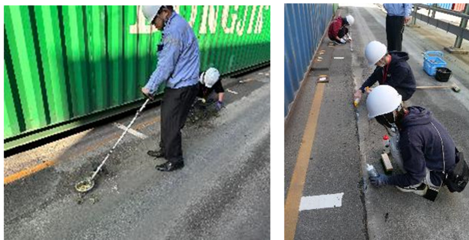
図 1—5 名古屋港鍋田埠頭における作業の様子。
