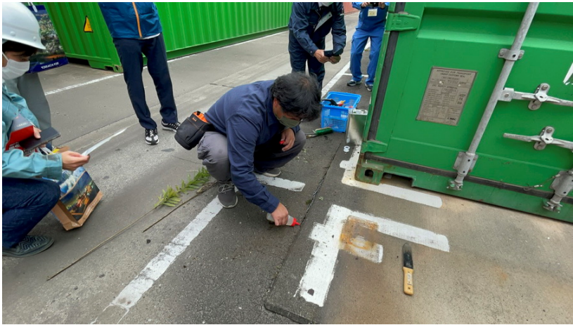
図 1－1 四日市港におけるシリコン樹脂充填によるテスト施工の様子
