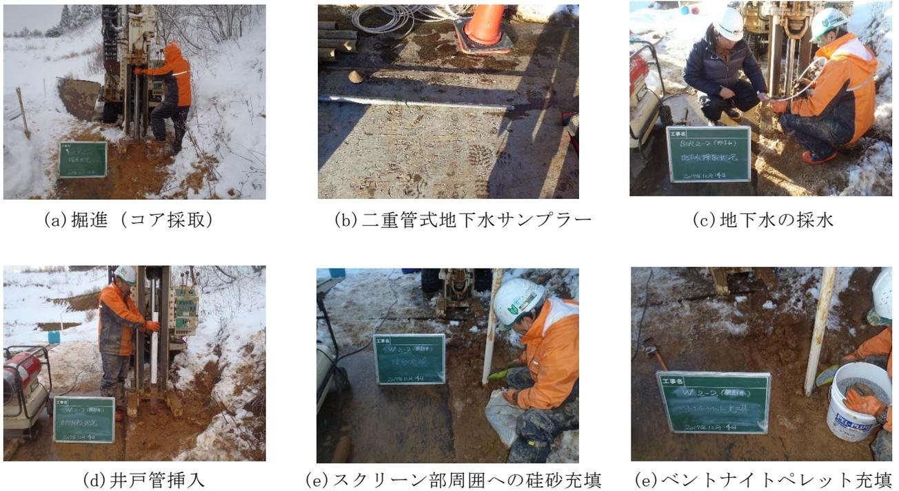
写真(2)-8 深度別土壌調査、深度別地下水調査における試料採取および観測井設置の実施状況
