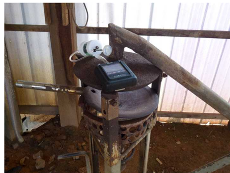
(b) 加熱器（不使用）付近の測定
