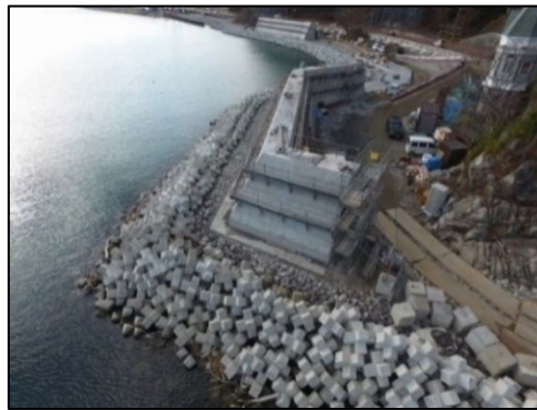
図(1)-7 2016年11月28日に撮影された宮古湾高浜地先の防潮堤工事の写真(岩手県情報公開)。
