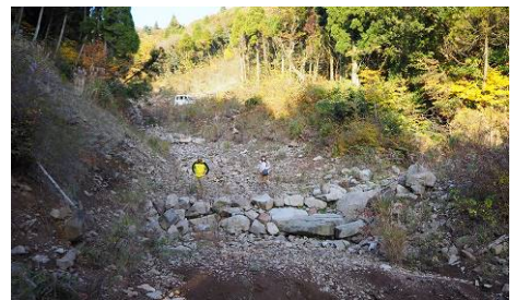
写真 3.11 現場発生材を利用した砂防堰堤
