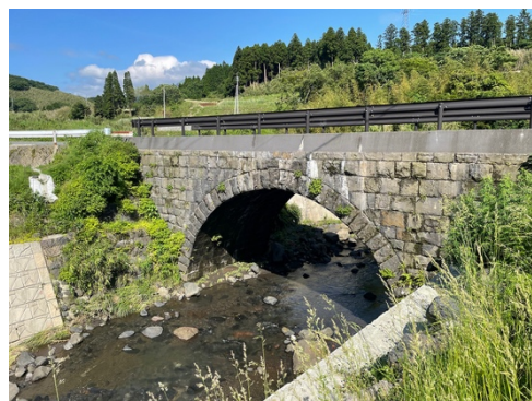
写真 3.3 周辺護岸や高欄部の地覆をコンクリートで補修補強された石橋
