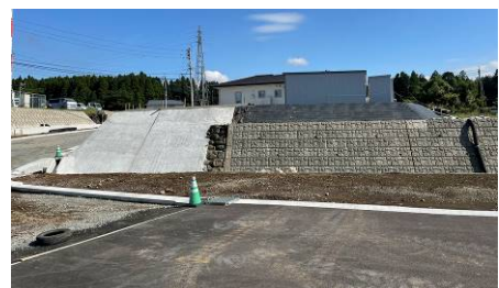
写真 3.12 コンクリートブロックに置き換えられた道路沿いの擁壁
