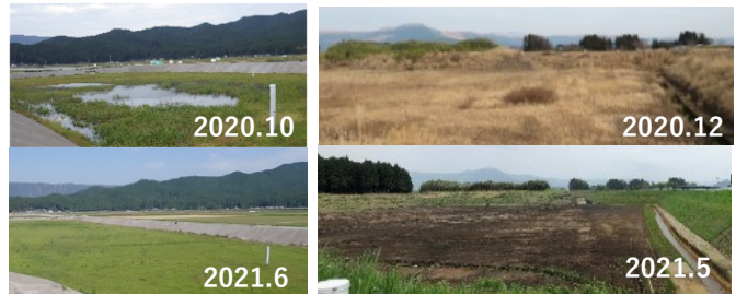
写真2.3 乾燥化処理前後の小倉遊水地（左）及び除草・土砂搬出前後の小野遊水地（右）
