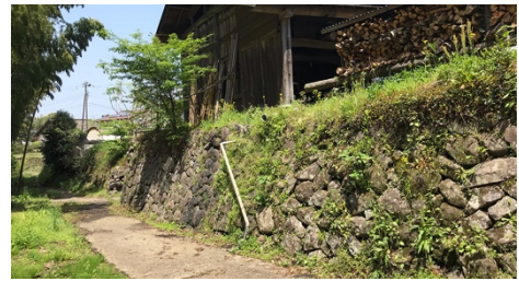
写真 3.8 集落内の既存の野面石積み
