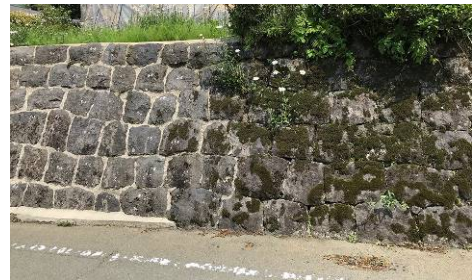
写真 3.9 集落内の既存の野面石積み(写真右)と練り積み(写真左)で修復された例
