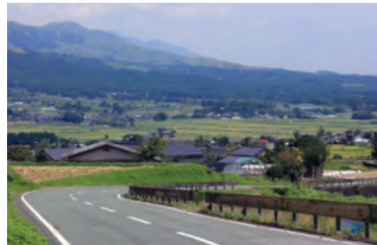
写真 3.14 スギ大径木を使用した木製ガードレールのイメージ (ガードレール部分はCG)
