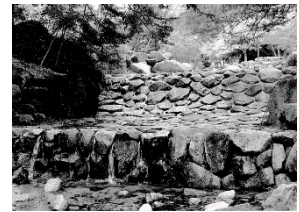
写真3.5 竣工当時の川庭園砂防施設 1)
