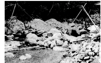
写真3.7 当時の工事状況。かぐらを使用した巨石の移動 1)
