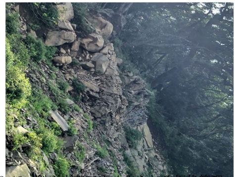
図2. 19 斜面上部でよくみられる板状節理
