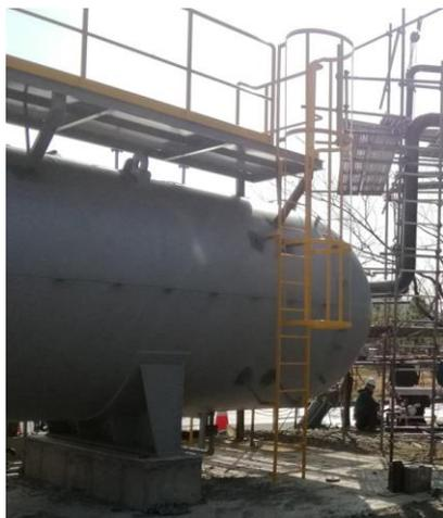
韓国・蔚山工業団地で焼却施設から化学工場への蒸気供給で利用されている蒸気アキュムレータ(蓄熱タンク)
